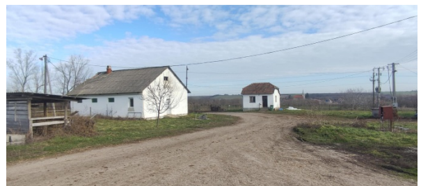
porta és öltöző épületek a telep észak-keleti sarkában a bejáratnál
